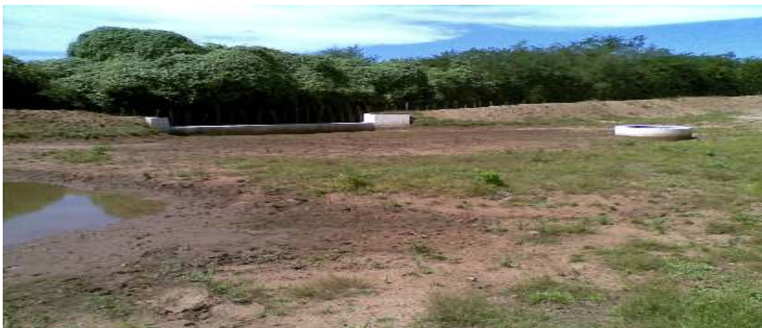
Figura 2. Barragem subterrânea no município de São José da Lagoa Tapada-PB.
