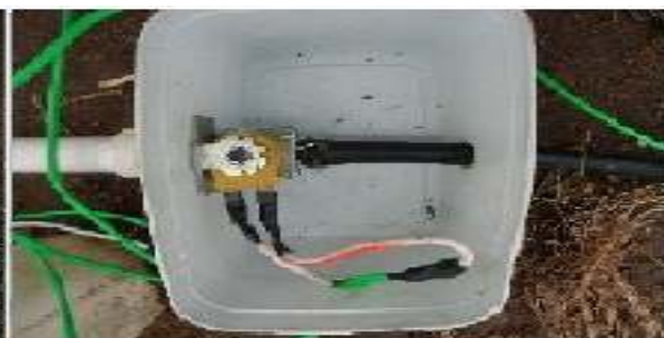
Válvula solenoide ligada à eletricidade liberando a água no sistema
