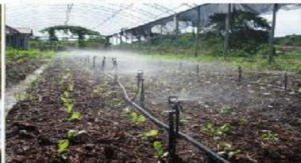
Fase inicial de processo de automatização do sistema de irrigação da colheita
