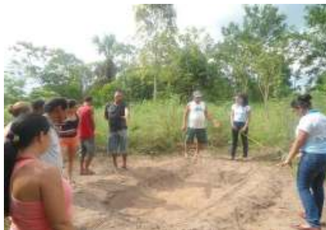
Imagem 2: Demonstração do pequeno viveiro de 0,80 x 1x 0,50 m escavado.
