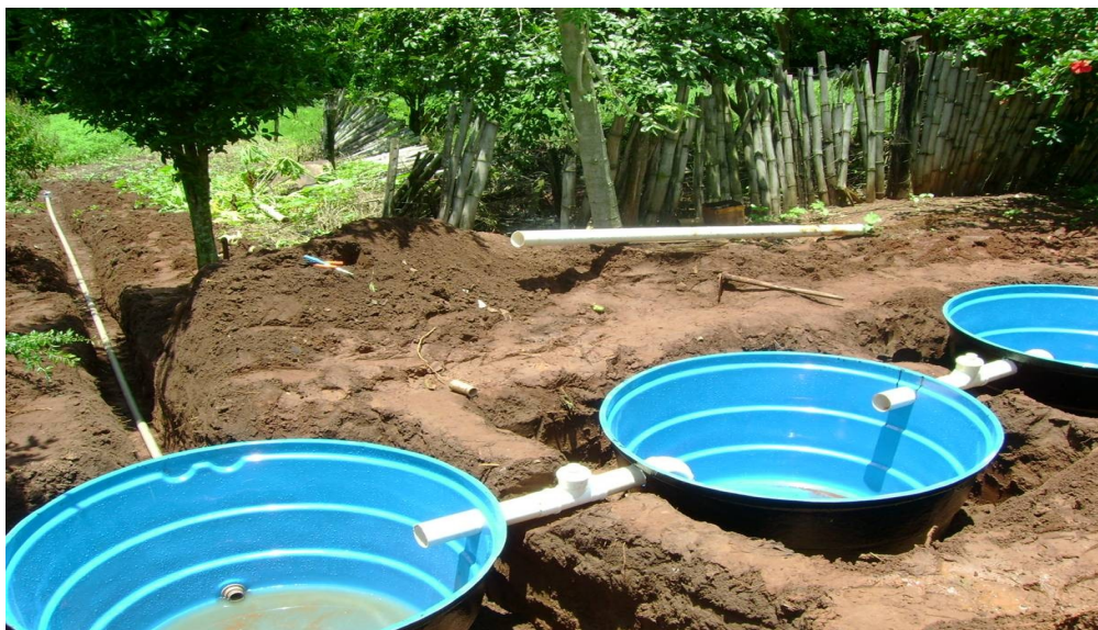
FIGURA 2. Implantação da fossa biodigestora em janeiro de 2007.
